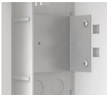
Fig. 2 - Fixação do suporte de tomada
