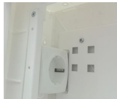
Fig. 3 - Fixação da tomada e dos perfis para instalação dos painéis (no ATI_RACK)
